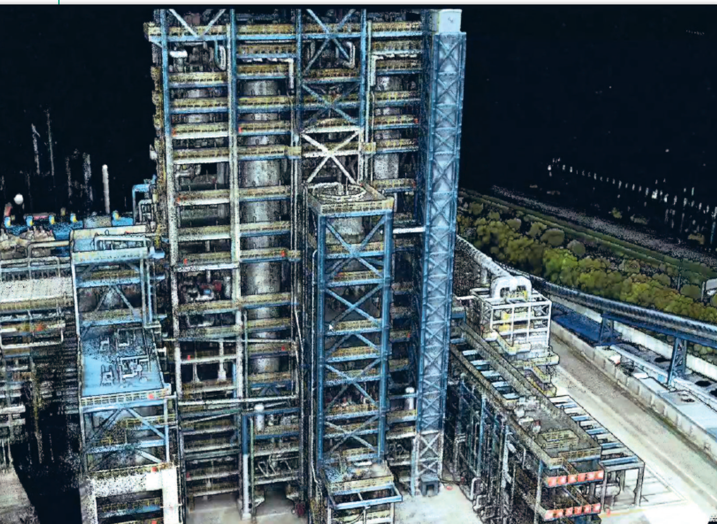
Wynik skanowania obiektów pionowych na placu budowy
